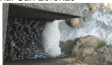
Fig. 1. Bocatoma del canal San Lorenzo
